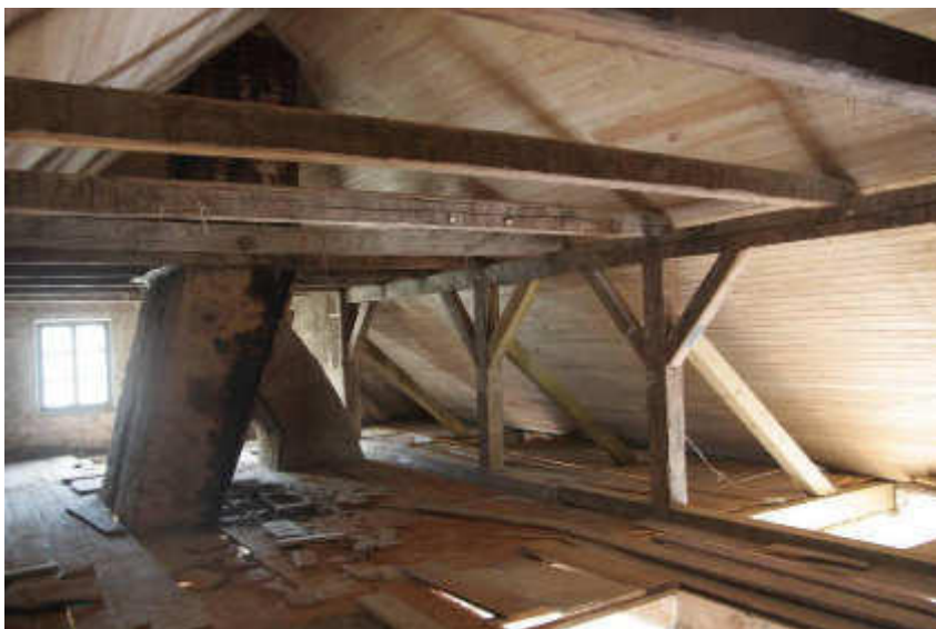
Mūrinis su tinko fragmentais kaminas K-2, pastogės medinė konstrukcija
